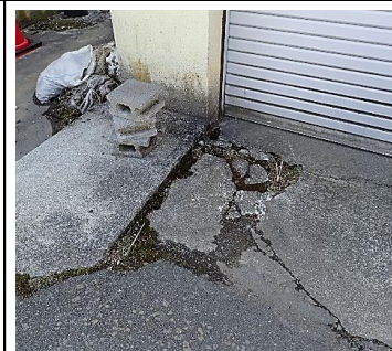
10.舗装材の様子
