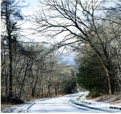
道路上の支障木
