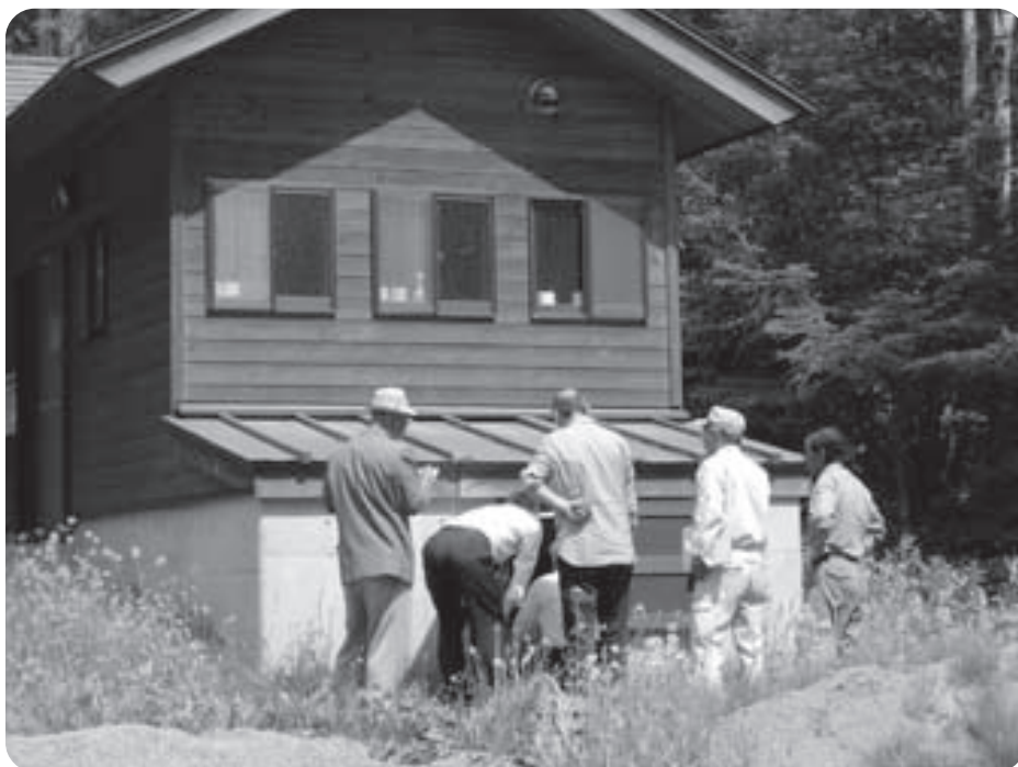
バイオトイレ機械室の調査
