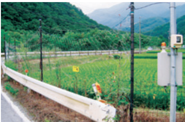
▲水田に設置された防護柵
