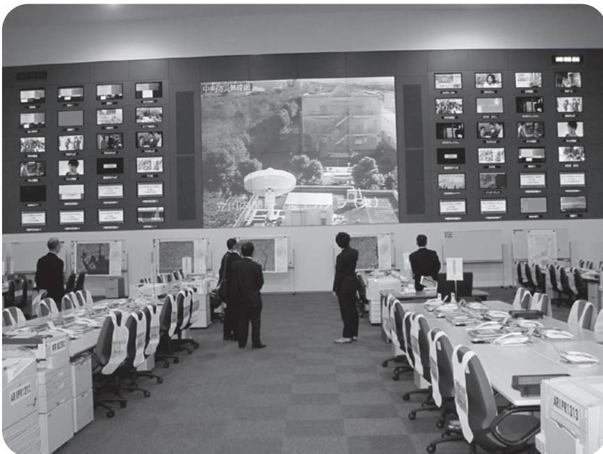
有明防災公園 オペレーションルーム
