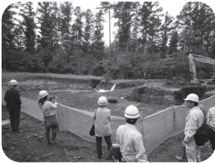
第5水源配水池工事
