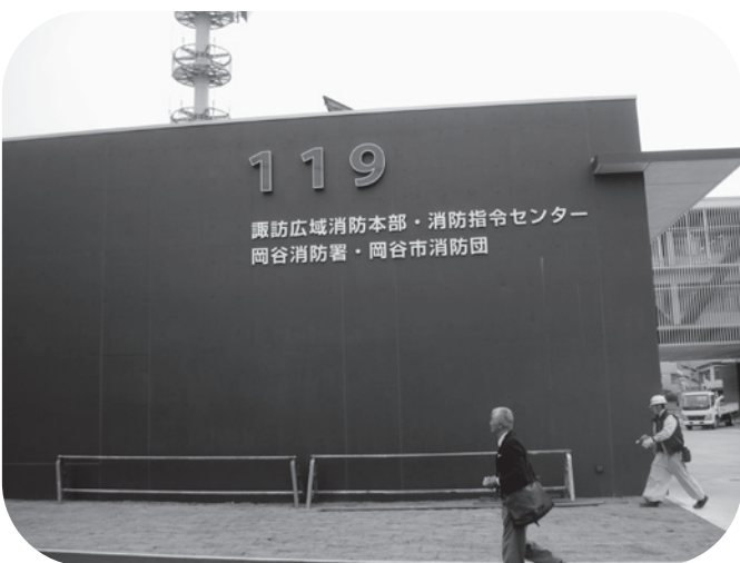
諏訪広域消防本部
