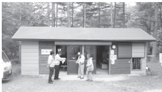
御山マレットゴルフ場 管理棟
