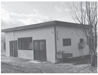
弓振農村広場管理棟 地盤沈下が起き、傾いている。
