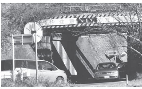
JR坂室ガード 多くの村民の生活道路となっている弘沢茅野線。ガード下が狭く、対面通行が難しい。
