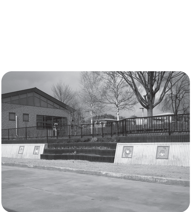
保育園未満児棟建設予定地
