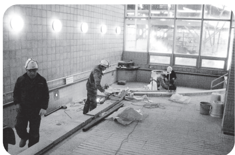
もみの湯改修工事
