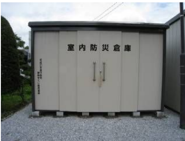
▲室内区 自主防災備品整備(平成21年度)
