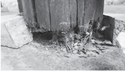
根元が腐食し機能していない危険な状態の軒柱
