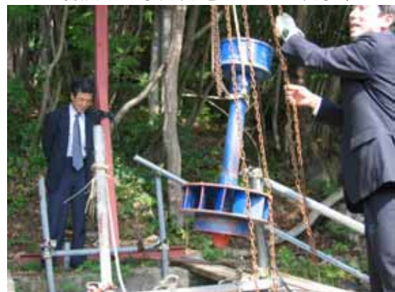
駒沢ミニ水力発電ベトナム製水車
