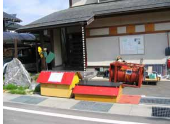
川上ミニ水力発電施設の全体（手前の木箱内）
