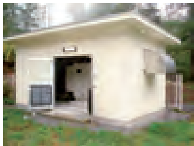
八ヶ岳自然郷水源 非常用発電機
