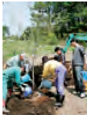
↑南原区公園整備事業 区民が力を合わせ、広場を整備しました
