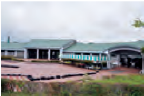
自然観察科学館屋根改修工事
