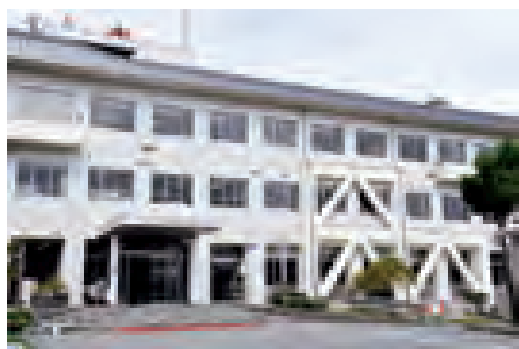
役場庁舎 耐震改修工事
