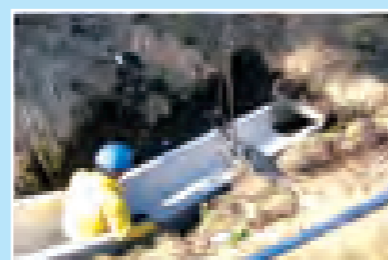
◆農業用水路の共同補修◆
