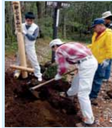
標柱を設置する様子
