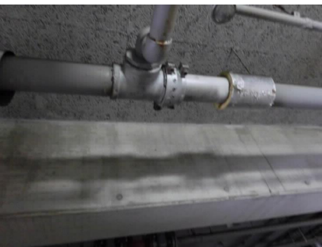
写真 15 漏水箇所は金属の管で補強【左】
