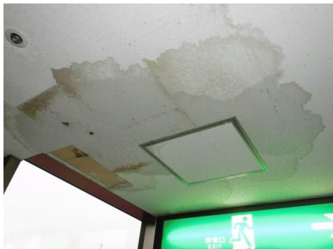
写真 9 3階デイサービス 雨が降るたびに広がるシミ【左】
