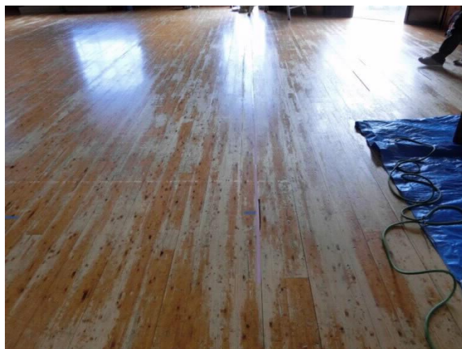
写真 2 ニスが剥げたリズム室の床（本棟）
