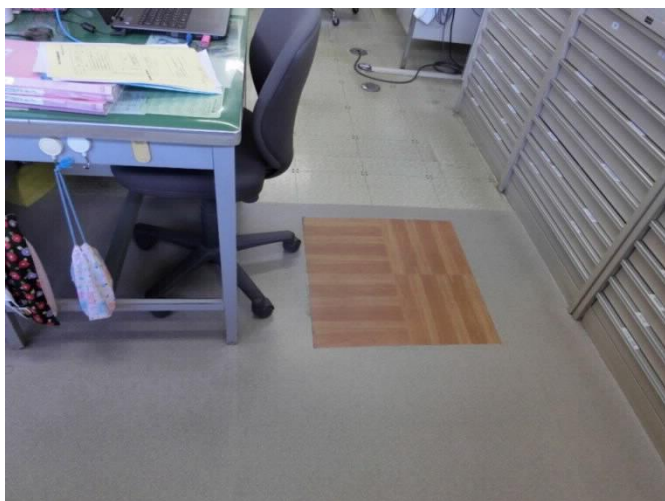
写真 1 職員室の床（本棟）
