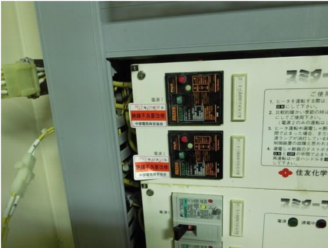
写真 11 雨水で漏電が発生して落ちたブレーカー【左】
