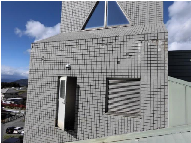
写真 5 外壁の剥離、ひび割れ（雨漏りの原因となっている）【左】
