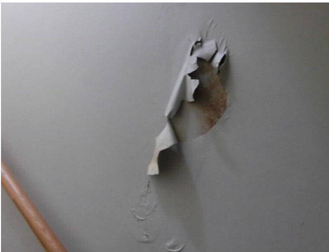
写真 13 漏水箇所の壁の塗装は浮いて剥がれている【左】
