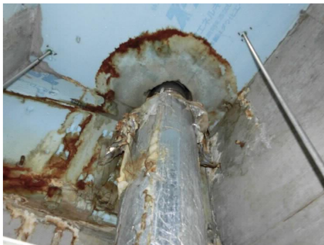
写真 7 室内を通る排水管からの雨漏り【左】
