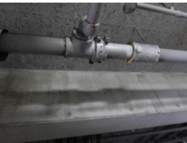
写真 15 漏水箇所は金属の管で補強【左】
