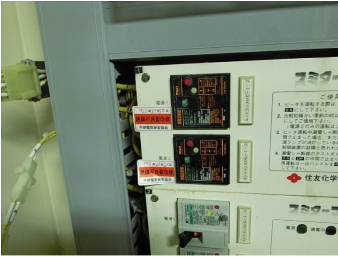
写真 11 雨水で漏電が発生して落ちたブレーカー【左】
